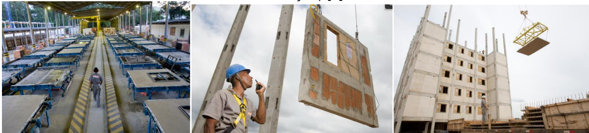
Figura 1. Sistema construtivo SHP (fabricação do painel, transporte do painel e obra em construção) [9].
