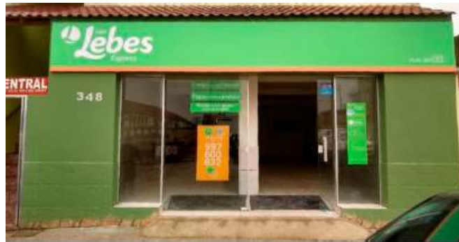
Figura 03: Aparato publicitário em desconformidade.
