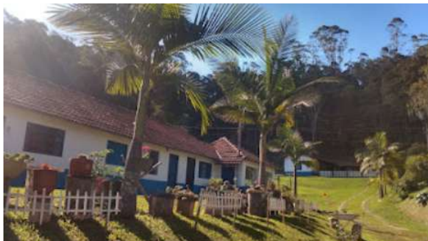
Figura 13: Conjunto de casas dos trabalhadores a esquerda e ao fundo casa do administrador
