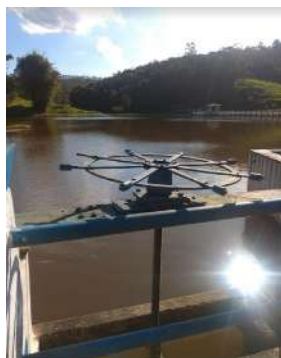
Figura 14: Comporta da represa
