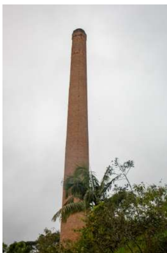
Figura 9: Chaminé da antiga destilaria.
