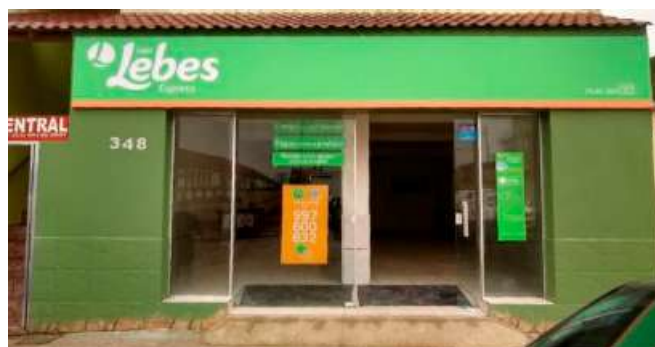
Figura 03: Aparato publicitário em desconformidade.
