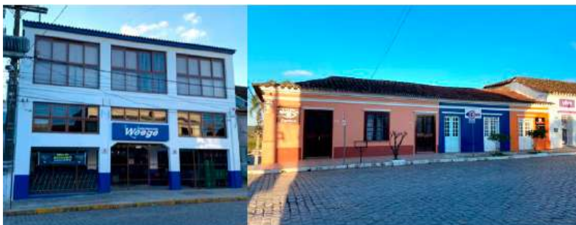
Figura 01: Fachada descaracterizante; Figura 02: Pintura descaracterizante.
