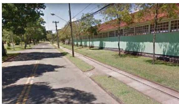
Figura 3: Avenida Araucária e a lateral de um galpão da empresa em 2022.
